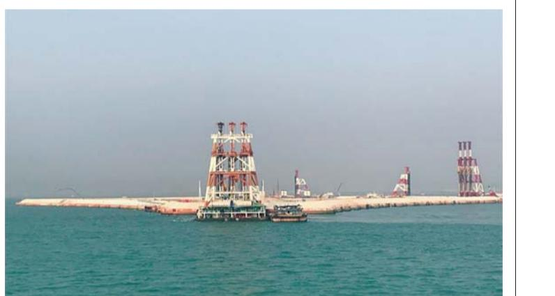
10月11日，五公司“砂桩2号”成功打下深中通道西人工岛S02标深水水泥搅拌桩(DCM)工程第一根桩。
