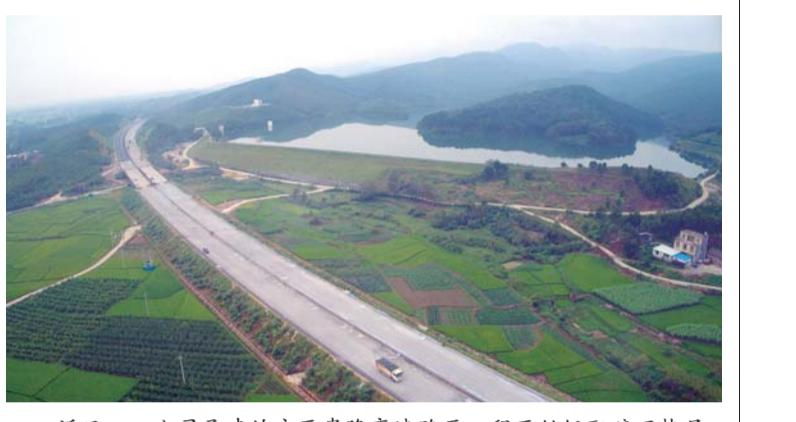
近日，四公司承建的广西贵港高速公路工程开始级配碎石垫层、水泥稳定碎石基层、基层、排水工程、路缘石、路肩透水预应力块等附属工程施工。
