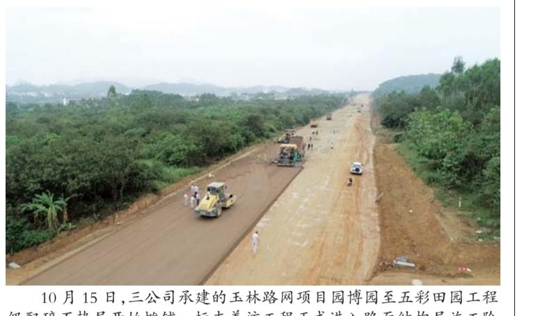
10月15日，三公司承建的玉林路网项目园博园至五彩田园工程级配碎石垫层开始摊铺，标志着该工程正式进入路面结构层施工阶段。
