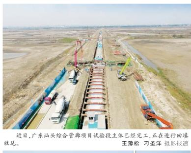
近日,广东汕头综合管廊项目试验段主体已经完工,正在进行回土回填收底。 王雅彬 刁圣洋 摄影报道
