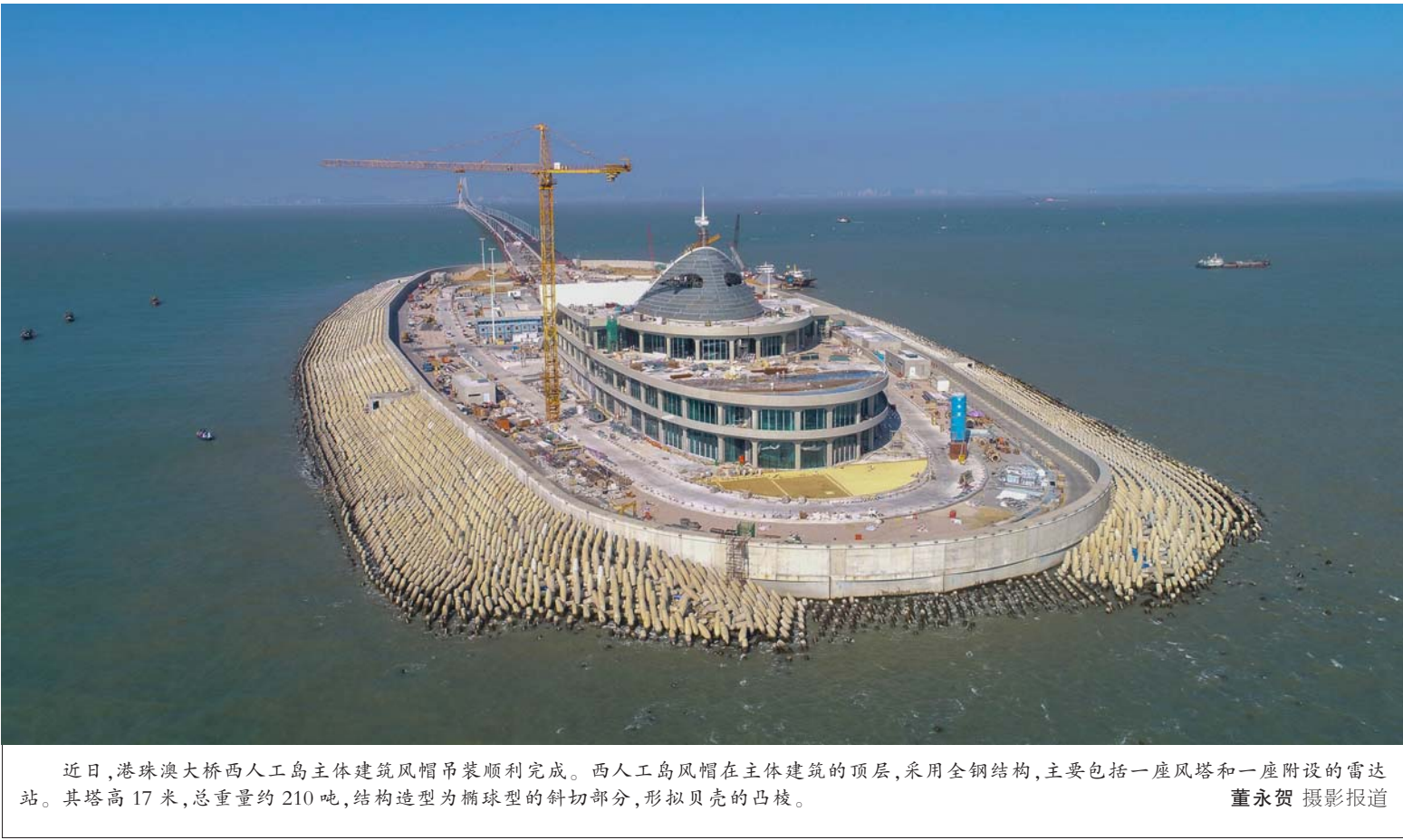
近日，港珠澳大桥西人工岛主体建筑风帽吊装顺利完成。西人工岛风帽在主体建筑的顶层，采用全钢结构，主要包括一座风塔和一座附设的雷达站。其塔高 17 米，总重量约 210 吨，结构造型为椭球型的斜切部分，形似贝壳的凸棱。 董永贺 摄影报道
