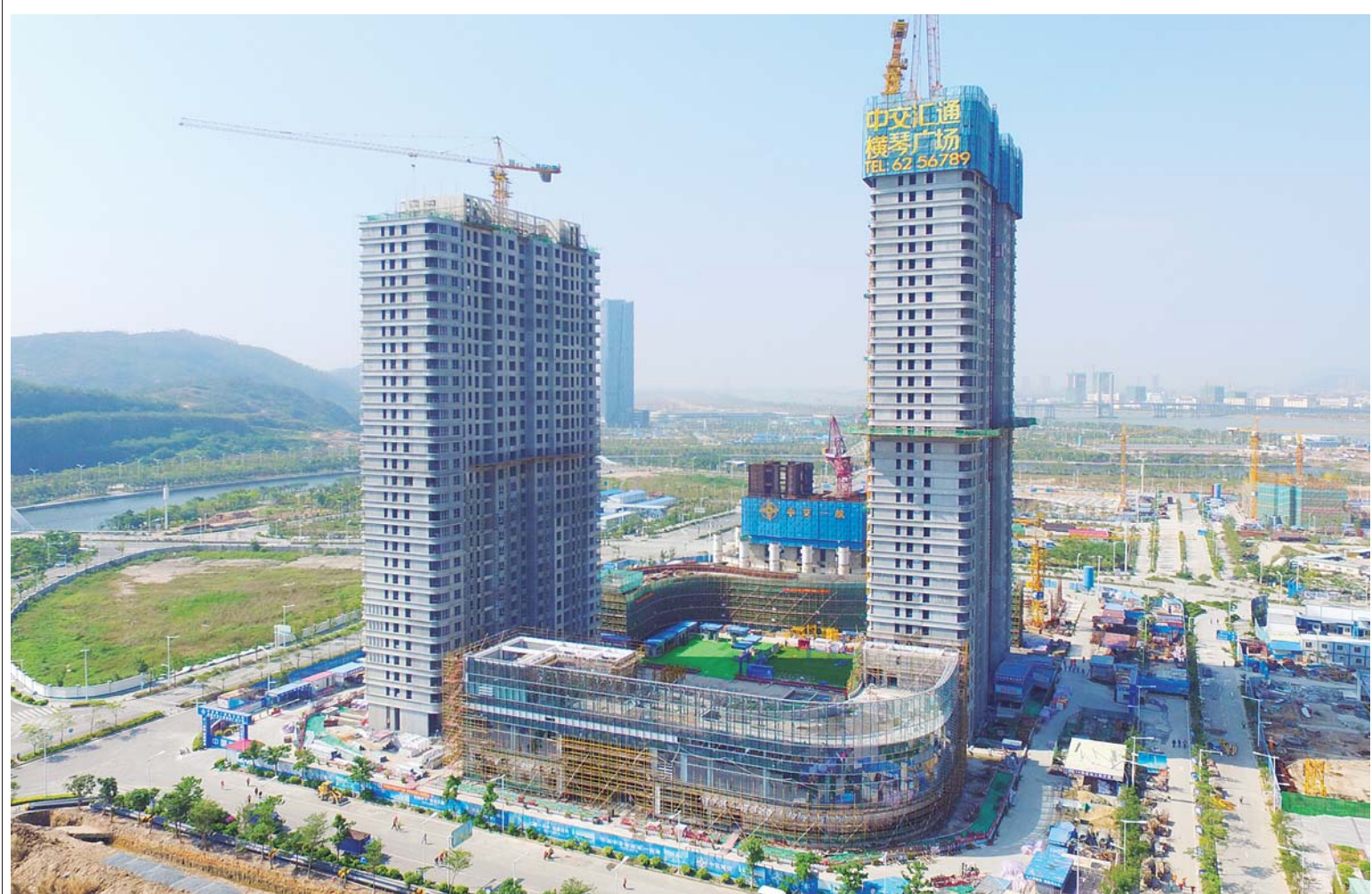
日前,四公司承建的中交汇通横琴广场工程1、2号公寓楼主体结构顺利封顶,正在进行二次砌筑施工以及内墙抹灰施工。王旸 摄影报道
