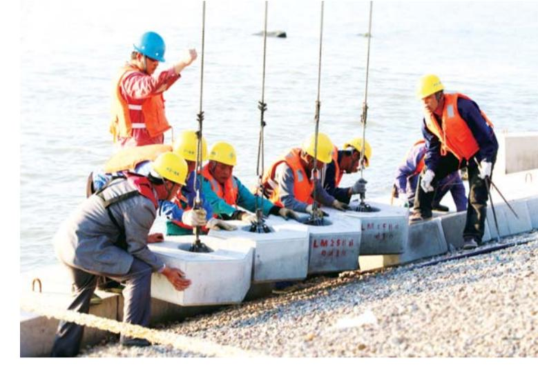
近日，在长江南京以下12.5米深水航道治理工程中，项目部积极践行“创新驱动发展”的理念，青年职工自主研发了新型六角螺母块专用吊具，提高安装工效3倍之多。
